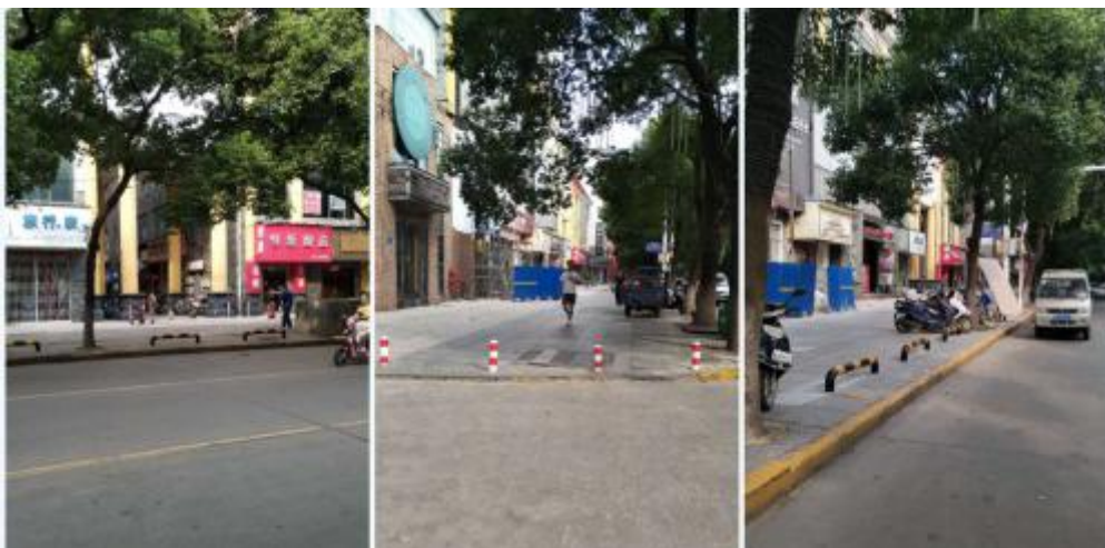
环城路人行道安装的障碍桩和阻车杆
